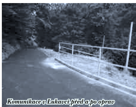
Komunikace v Lukavci před a po opravě
